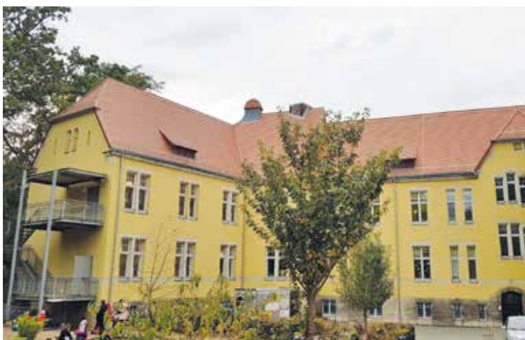
Hospital St. Jakob Köthen Dachsanierung Wolfgangsstift mit Kindergarten
